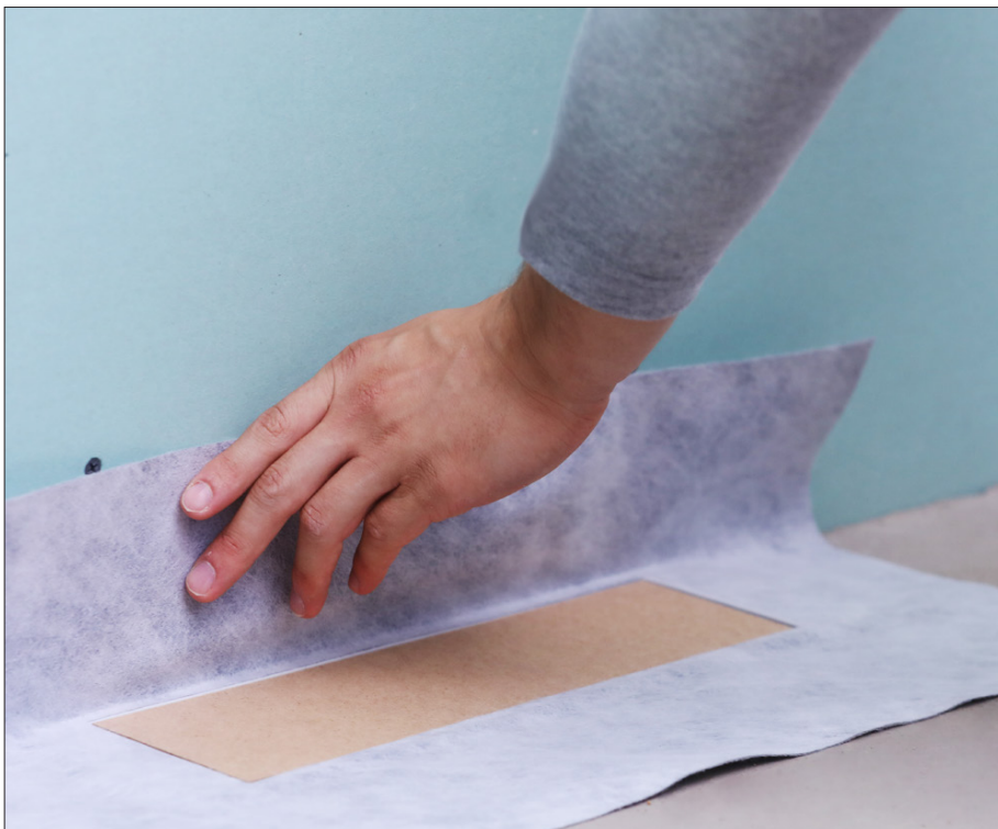
Die flexible DallFlex-Dichtmanschette zur Aufnahme von Verbund- sowie Bahnenabdichtung gemäss DIN 18534
